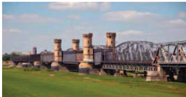
Rys. 10. Widok mostu w Tczewie zbudowanego wg projektu Carl'a Lentz'a
