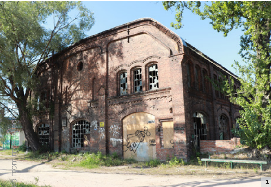
Fot. 1. Historyczny budynek Formierni
