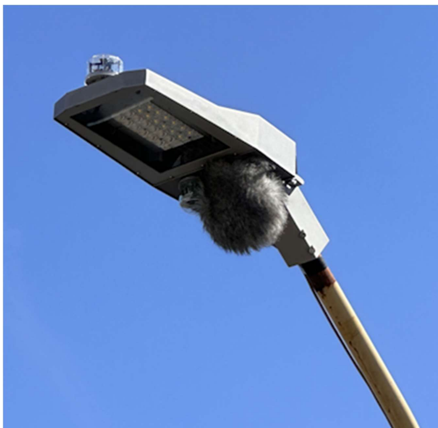
Fot. 13. Lampa inteligentna drogowa ILED z Modułem Głównym, Modułem Radarowym, Modułem Sondy Akustycznej i modułem czujnika temperatury barwowej oświetlenia otoczenia
