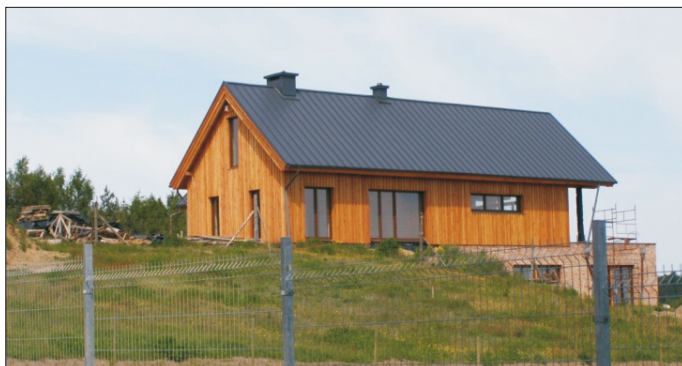
Fot. 1. Zdjęcie analizowanego budynku
