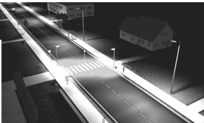
5. Przykład przejścia dla pieszych z zastosowanym dodatkowym oświetleniem o: [13]
