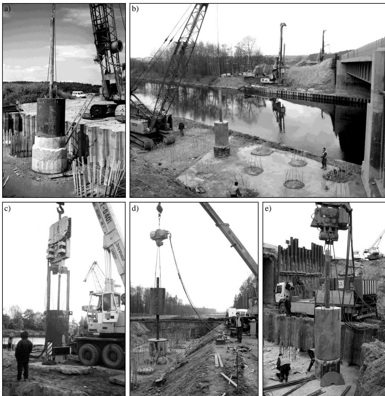
Rys. 6. Dynamiczne badania nośności pali wierconych:
