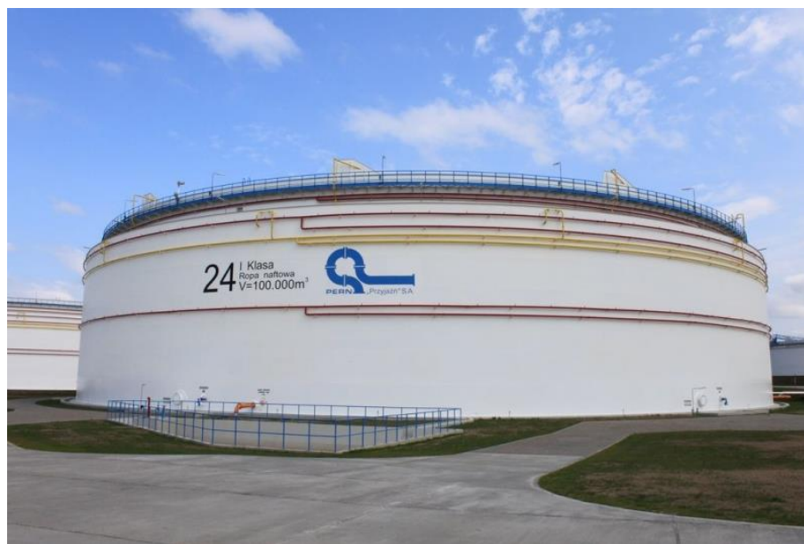
Rys. 2.1. Największy w Polsce zbiornik na ropę surowcową o pojemności V=100.000 \text{ m}^3 znajdujący się w Bazie Adamowo PERN S.A. ( http://www.mostostal-plock.com.pl )
