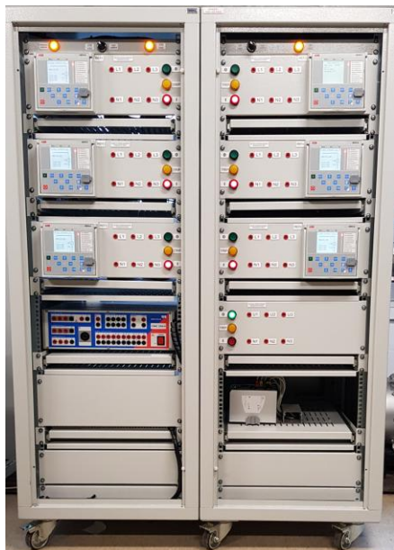
Rys. 2. Widok stanowiska badawczego
