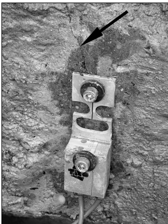
Rys. 4. Pęknięcie w rejonie zamocowania czujnika Rys. 5. Pęknięcie powierzchniowe obok czujnika
