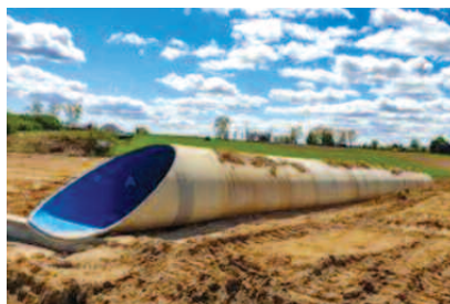
Fot. 2. Przepust drogowy z tworzywa GRP o profilu niekołowym o wymiarach 3000/2250 na trasie S6 Szemud – Gdynia Wielki Kack [1]
