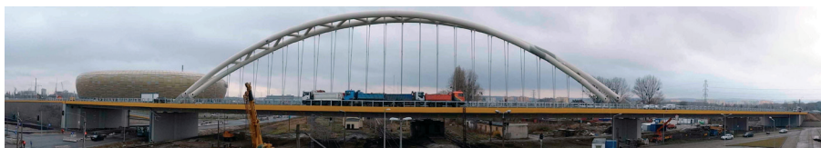
Rys. 7. Ustawienie U2 obciążenia próbnego
