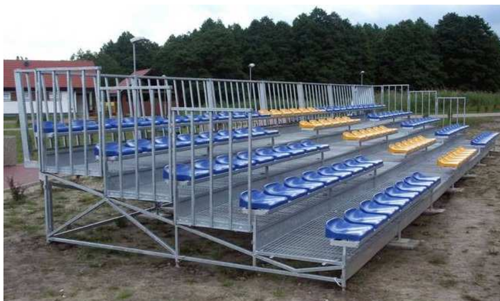
Fot. 2.2 Metalowa trybuna demontowalna ( www.trybunysportowe.pl ).
