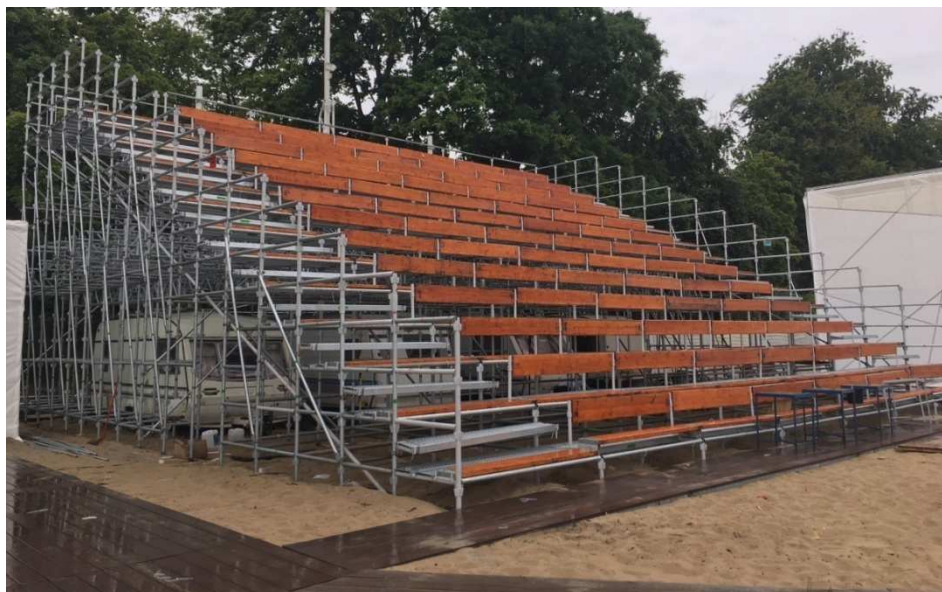
Fot. 6.1 Tymczasowa trybuna stalowa (widok z boku).
