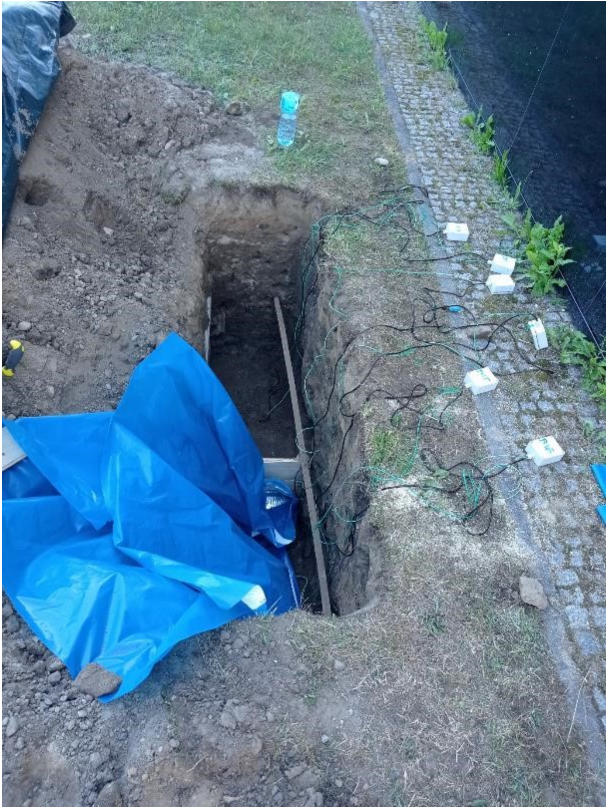
Rysunek 42. Przygotowanie folii paroizolacyjnej wraz z miernikami
