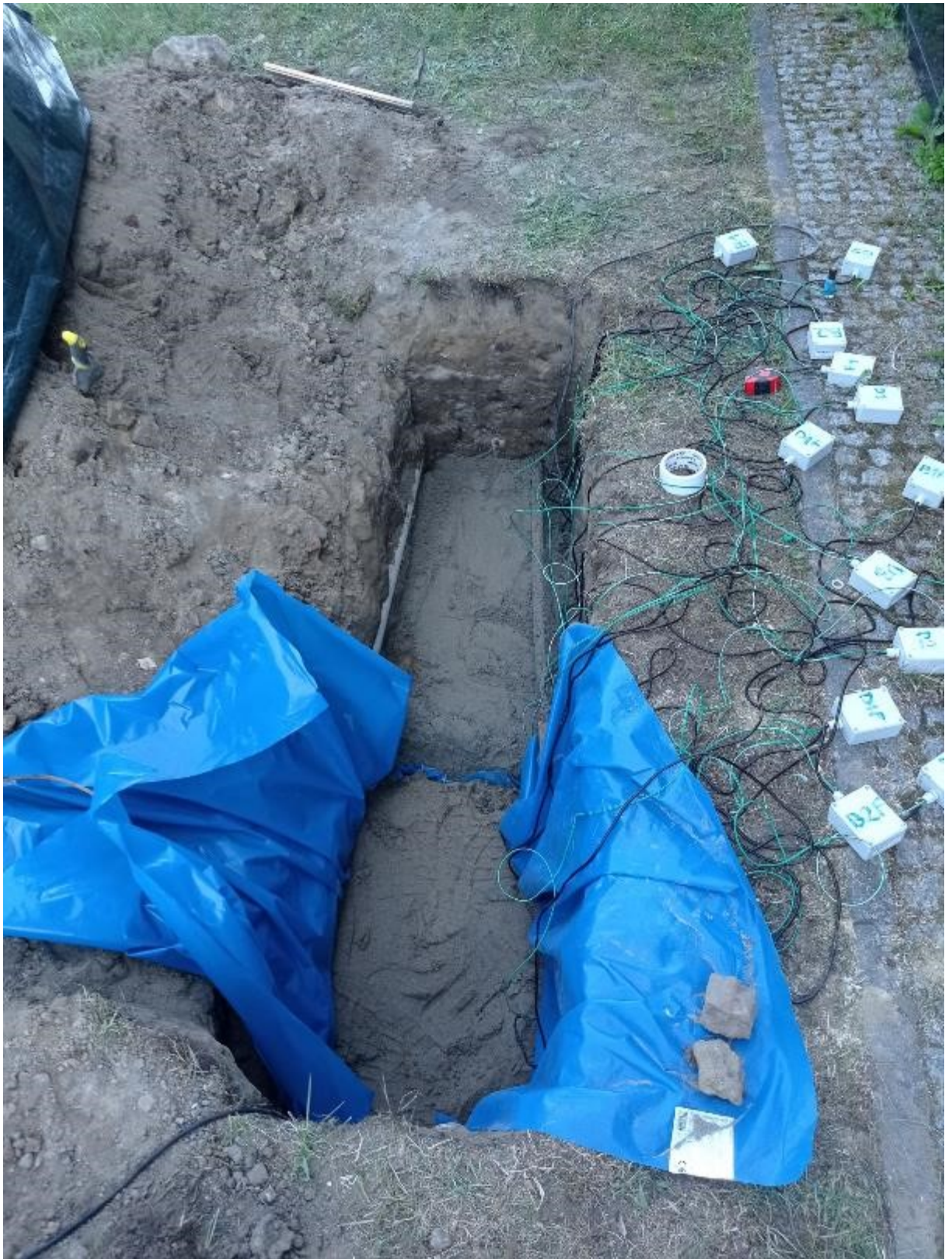
Rysunek 45. Zakończenie umieszczania betonitu
