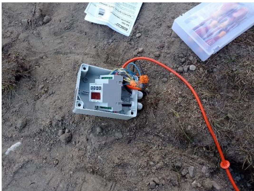
Rysunek 50. Przyłączenie przewodu grzejnego – zakończenie budowy stanowiska pomiarowego
