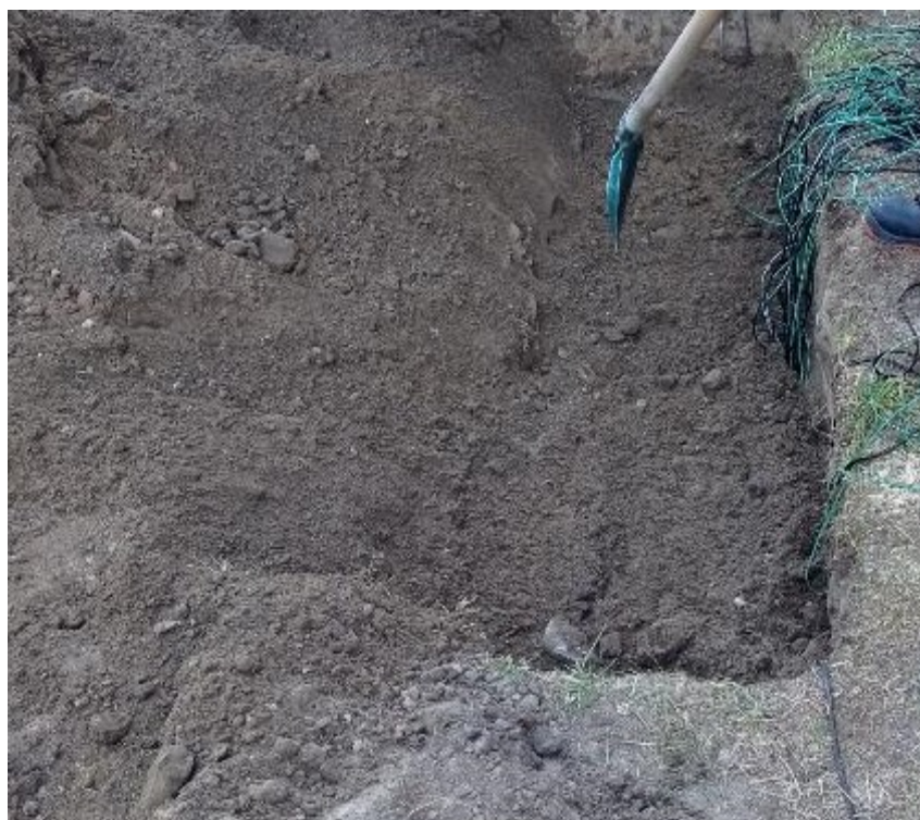
Rysunek 49. Stanowisko pomiarowe po zasypaniu ziemią rodzimą
