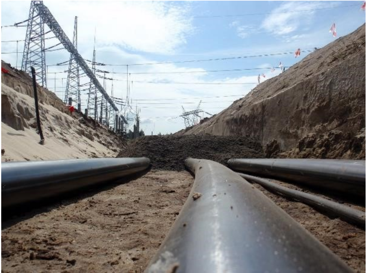
Rysunek 9. Proces układania linii kablowej. Kable zasypuje się wypełnieniem kontrolowanym, tu – mieszaniną piasku i cementu. Pomiędzy kablami z prawej strony widać ułożony kabel ECC o mniejszym przekroju (ang. Earth Continuity Conductor ). Rysunek pochodzi z firmy Eltel Networks
