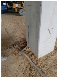
Rys. 5. Instalacja uziemiająca rozmieszczona na górnej powierzchni podbudowy (fot. S. Świątek-Żołyńska)
