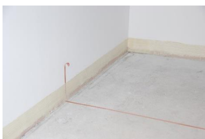
Rys. 1. System antyelektrostatyczny oparty na wykładzinie ESD: a) podkład betonowy z widoczną instalacją uziemiającą, b) warstwa wierzchnia z wykładziny ESD (fot. S. Świątek-Żołyńska)
