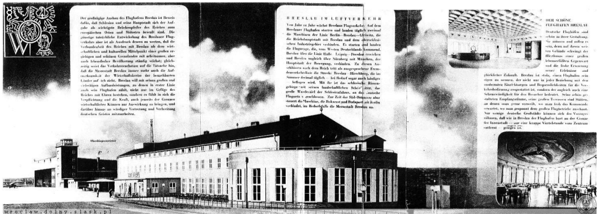
Il. 1.131. Folder reklamowy Portu Lotniczego Wrocław-Gądów, 1936. W tle widoczny hangar z wieżą. Źródło: https://polska-org.pl/791769,foto.html?idEntity=509856 [dostęp: 13.03.2020].
