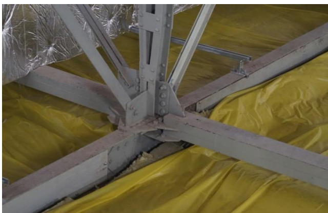
Il. 3.07. Nitowana konstrukcja stalowa w dawnym hangarze lotowskim. Zdjęcia z remontu prowadzonego w 2016 r. Fot. J. Szczepański.
