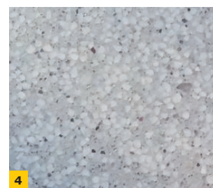
FOT. 1–4. Zróżnicowanie wizualne posadzki typu lastrico w zależności od rodzaju kruszywa: bazaltowe (1), kwarcowe (2), granit z marmurem (3), dolomit drobny (4);
