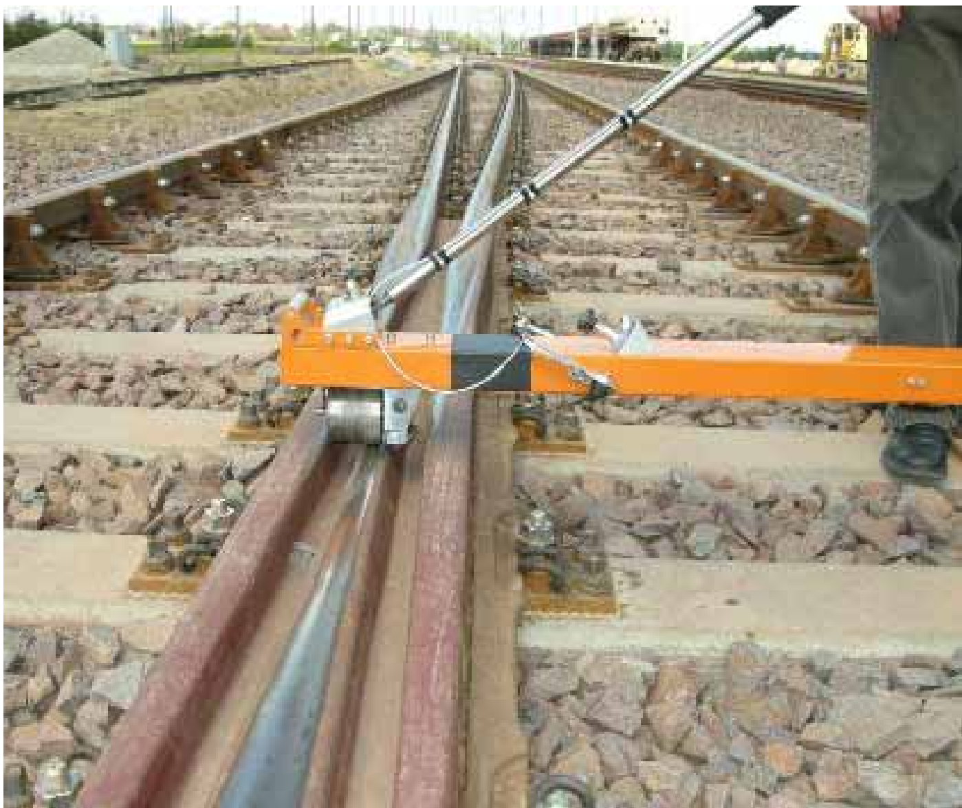
6. Przejazd przez dziób krzyżownicy
