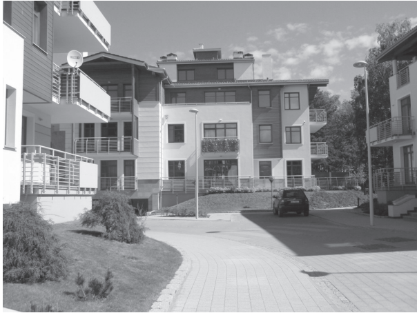
Ryc. 1. Nowa zabudowa mieszkaniowa z parkingami podziemnymi (zdjęcie autora)
