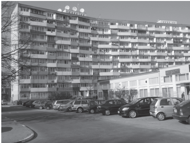
Ryc. 3. Parkingi zabudowy z lat sześćdziesiątych, Gdańsk - Przymorze (zdjęcie autora)
