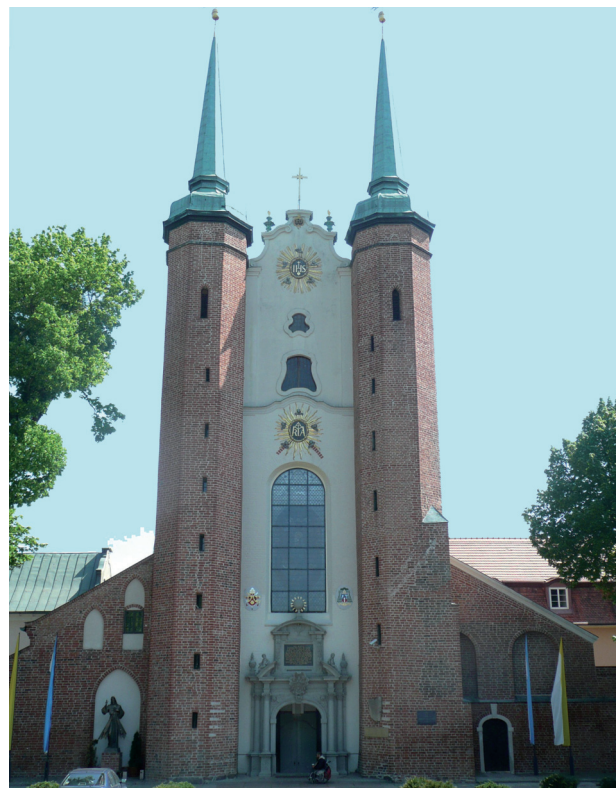
Il. 10. Współczesna fasada kościoła pocysterskiego (katedry) w Oliwie z fragmentem włączonym do niej reliktu budynku dawnego browaru. Stan z 2011 r. (fot. A. Piwek)
