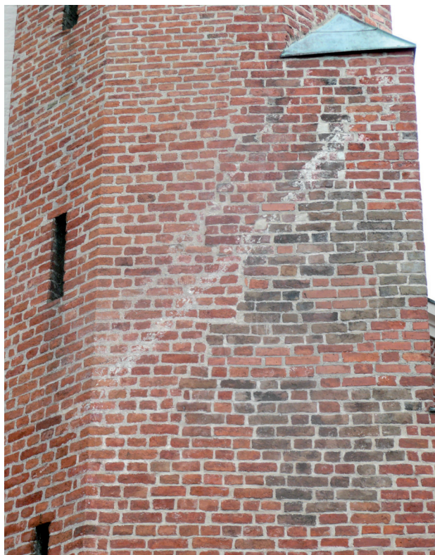
Il. 9. Fragment zachodniej ścianki południowej klatki schodowej z zarysem mającym odpowiadać krzywiznie dachu dawnego browaru. Stan z 2011 r. (fot. A. Piwek)
