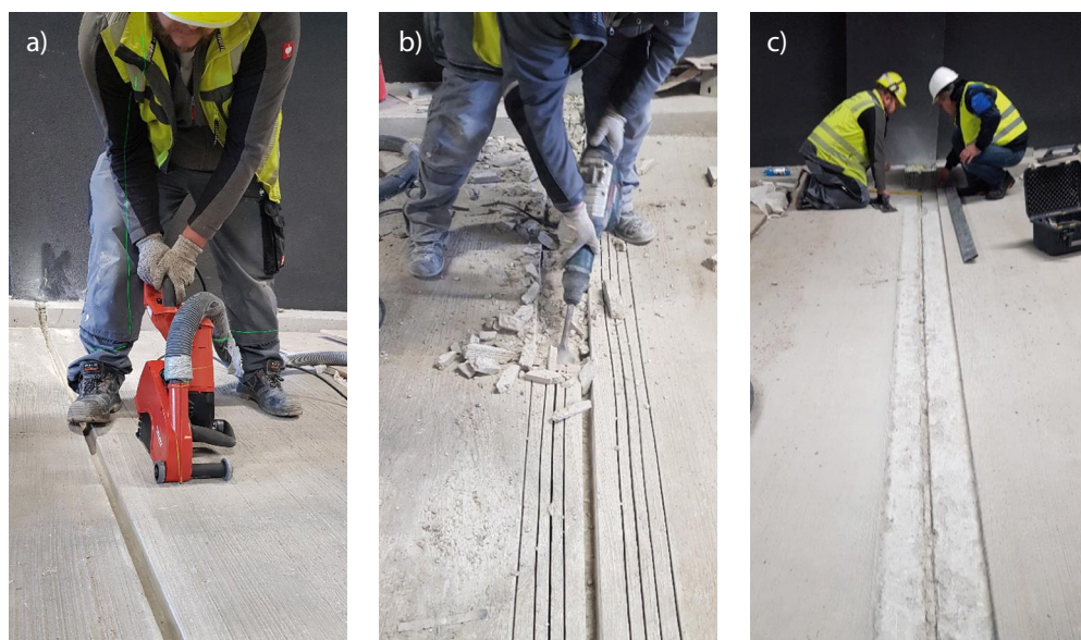
Rys. 10. Etapy naprawy dylatacji konstrukcyjnej: a) trasowanie bruzdy, b) wycięcie i wykucie bruzdy, c) pogłębienie i oczyszczenie bruzdy [26]
