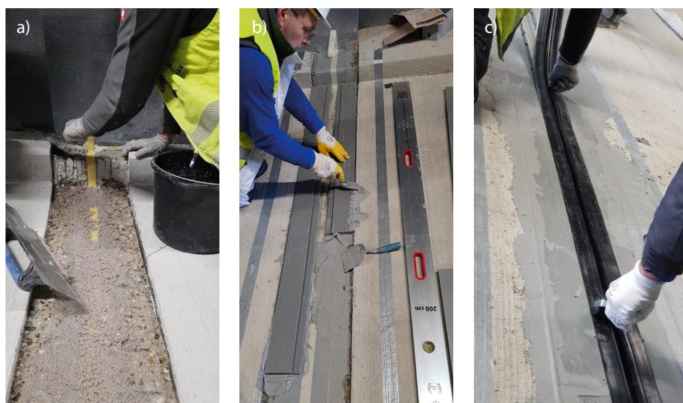
Rys. 11. Etapy naprawy dylatacji konstrukcyjnej: a) reprofilacja ubytków, b) ułożenie kleju montażowego, wklejenie membrany i paneli dylatacyjnych, c) wklejenie nakładki gumowej [26]
