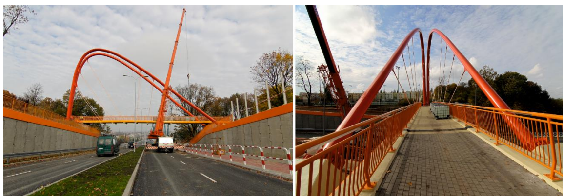
Rysunek 6.13 Widok na kładkę nad ul Ogińskiego w Bydgoszczy
