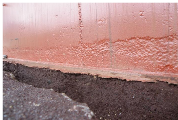
Rys. 1.25. Wżery na płaszczu zbiornika, powstałe w wyniku zacieku wody pod izolację [12]
