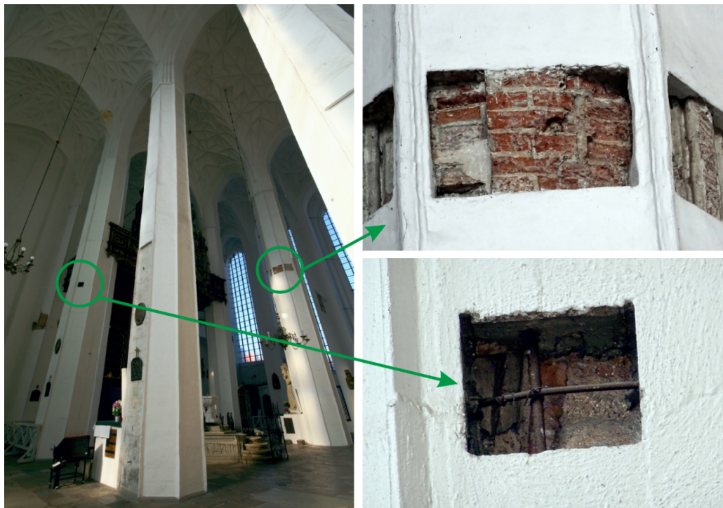
Rys. 7.46. Otynkowane filary z odkrytymi miejscami pokazującymi szczegóły muru i zbrojenia
