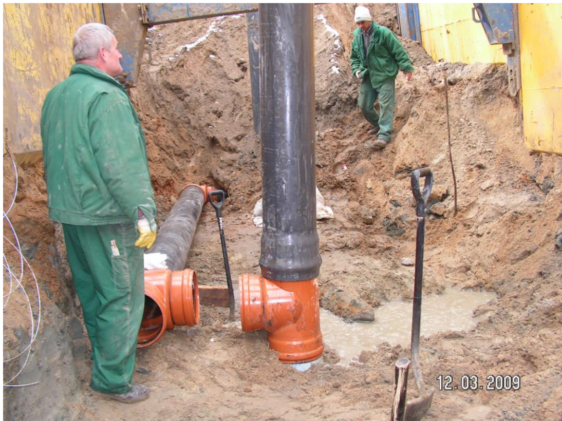
Rys. 6. Połączenie studni z kolektorem
