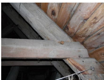
Fot. 10. Nowa Kościelnica -połączenie krokwi z jętką widoczne jest oznaczenie ciesielskie. (fot. autor)
