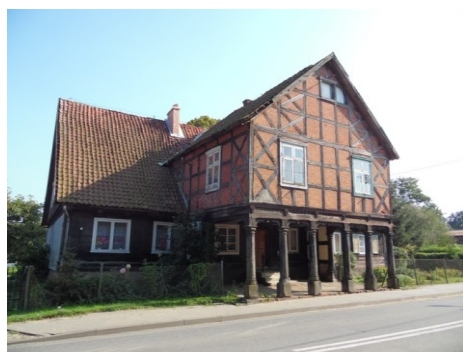
Fot. 14. Dom podcieniowy w Żuławkach (fot. autor)
