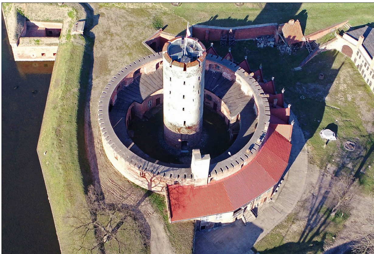
Ryc. 1. Wieża obecnie – widok lotniczy, stan w 2020; fot. W. Samól.
