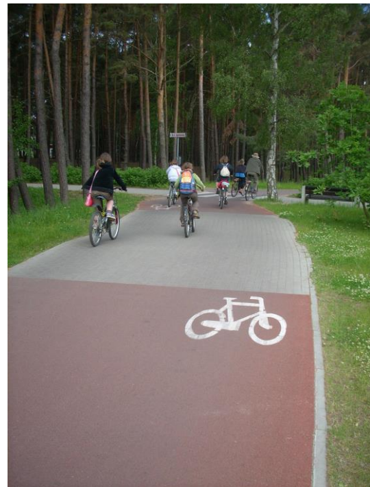
Fot.16. Zmiana rodzaju i koloru nawierzchni oraz „garby” na ścieżce rowerowej przed przejściem dla pieszych.
