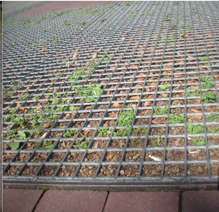
Fot.4. Przepuszczalna nawierzchnia z metalowych krat
