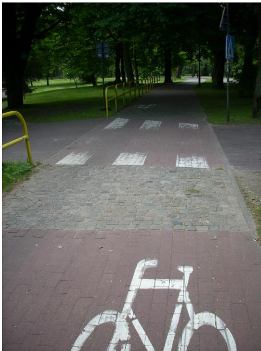
Fot.15. Zmiana koloru i rodzaju nawierzchni ścieżki rowerowej przed przejściem dla pieszych.
