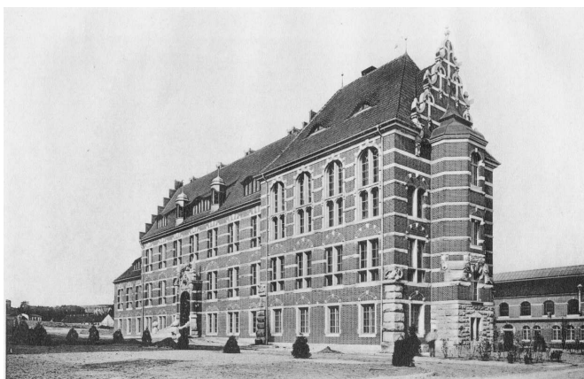
Rys.1. Budynek Instytutu Elektrotechnicznego, 1904 (zbiory Sekcji Historycznej PG)
