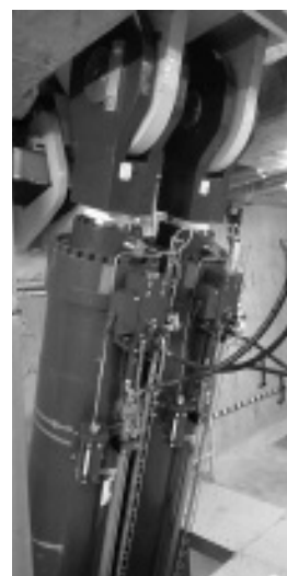
Fot. 2. Dźwigniki hydrauliczne (kładka w pozycji otwartej)
