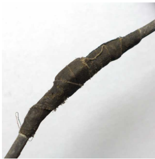
Rys. 13. Przykład łączenia kabli bez użycia złączek
