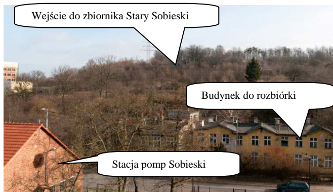
Fot. 1. Widok wzgórza Szubienicznego i stacji pomp Sobieski z budynku LINTE 2 przy ul. Sobieskiego 5
