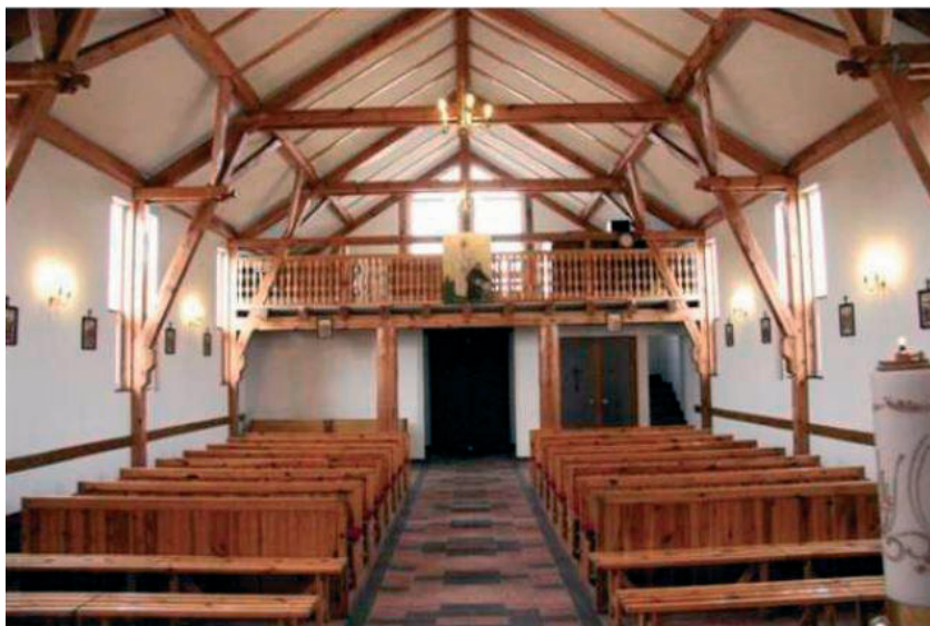
Fot. 4. Kościół pw. Świętego Ojca Pio w Zamościu koło Bydgoszczy. Autor: mgr inż. arch. Paweł Władysław Kowalski, foto: Paweł Władysław Kowalski
