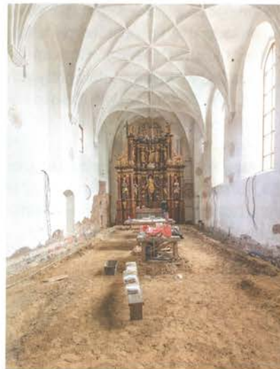
13. Barczewo. Kościół Świętego Andrzeja. Prezbiterium w trakcie prac konserwatorskich, 2021. Fot. Damian Kwiecień – Gorek Restaura.
