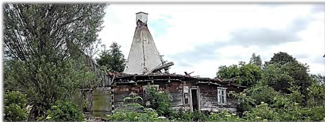
Ryc. 3.5 Zdewastowany budynek mieszkalny w Marzęcinie, fot. A. Rubczak, 2017.
