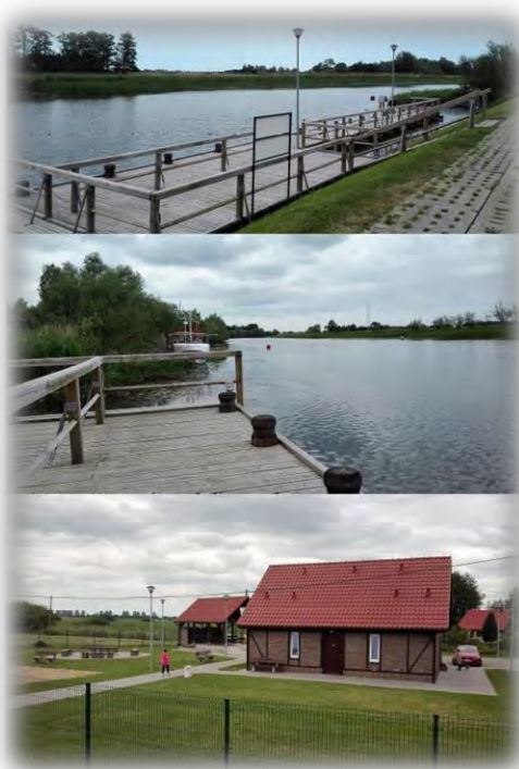
Ryc. 3.8. Przystań żeglarska z zapleczem sanitarnym na rzece Szarpawie w Osłonce, fot. A. Rubczak, 2018
