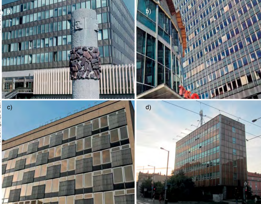
Rys. 2. Budynki z lekką obudową z początku okresu realizacji tego typu rozwiązań: a) budynek ZLS w Warszawie, b) budynek MHZ Uniwersal w Warszawie, c) hotel Cracovia w Krakowie, d) budynek biurowy we Wrocławiu
