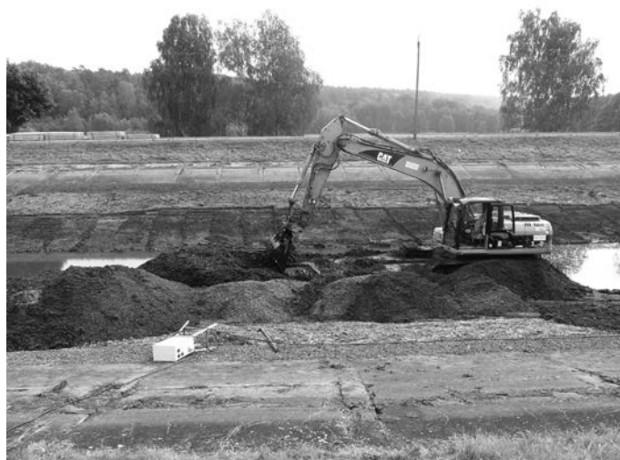
Rys. 3. Czyszczenie kanału z omułek i innych zanieczyszczeń 11.08.2014 roku (fot. W. Sterpejkowicz-Wersocki)
