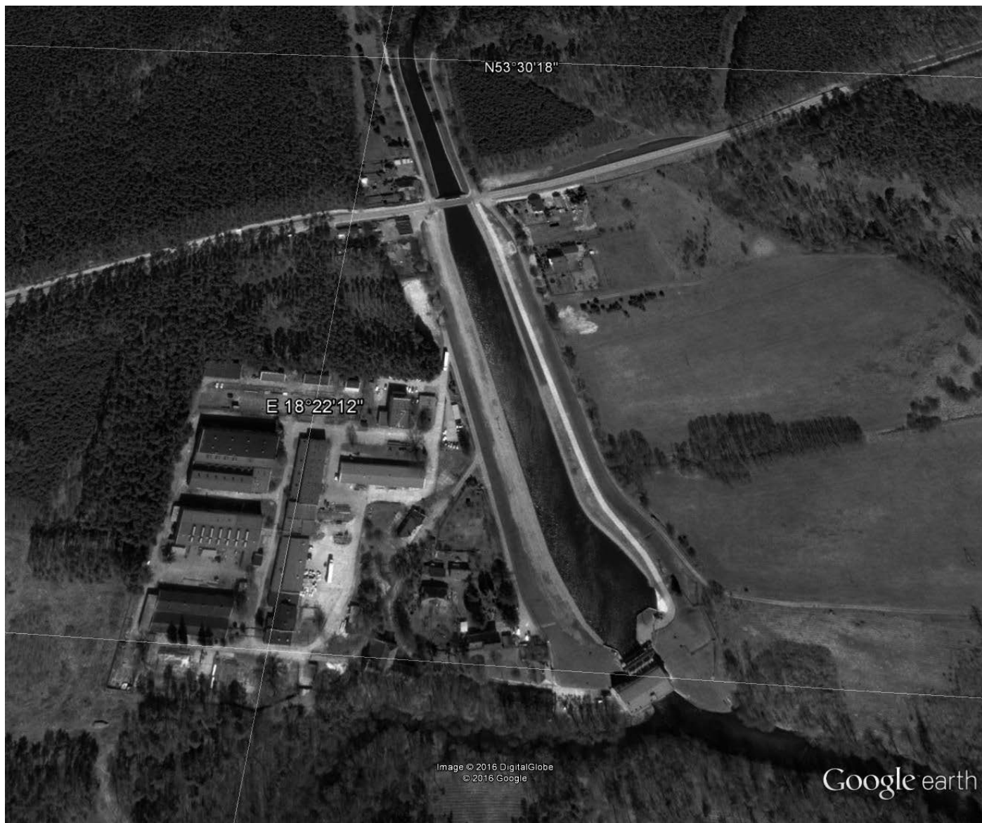
Rys. 2. Zdjęcie satelitarne kanału derywacyjnego EW Gródek – widoczna droga przecinająca kanał w miejscu jazu mostowego oraz elektrownia wodna u dołu zdjęcia (źródło: Google earth)
