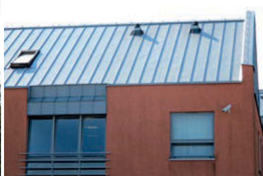
Rys. 8. Blachy stalowe w budownictwie mieszkaniowym
