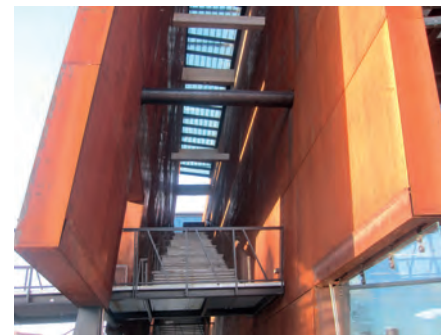
Rys. 5. Fasada obiektu użyteczności publicznej ze stali odpornej na korozję atmosferyczną – ECS Gdańsk
