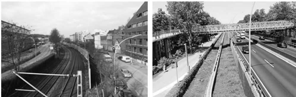
Fot. 10. Główne problemy przestrzennie zintegrowanego rozwoju metrozone na przykładzie rejonu IBA Hamburg: rdzeń komunikacyjny dla obsługi Harburger Binnenhafen w rejonie ulicy Karnapp; widok z kładki pieszej przy biurowcu Channel Tower (po lewej), Wihelmsburger Reichstraße przecinającej Wyspę i tereny IGA 2013 widok na tymczasowa pieszą kładką z wagonu monorail (po prawej)
