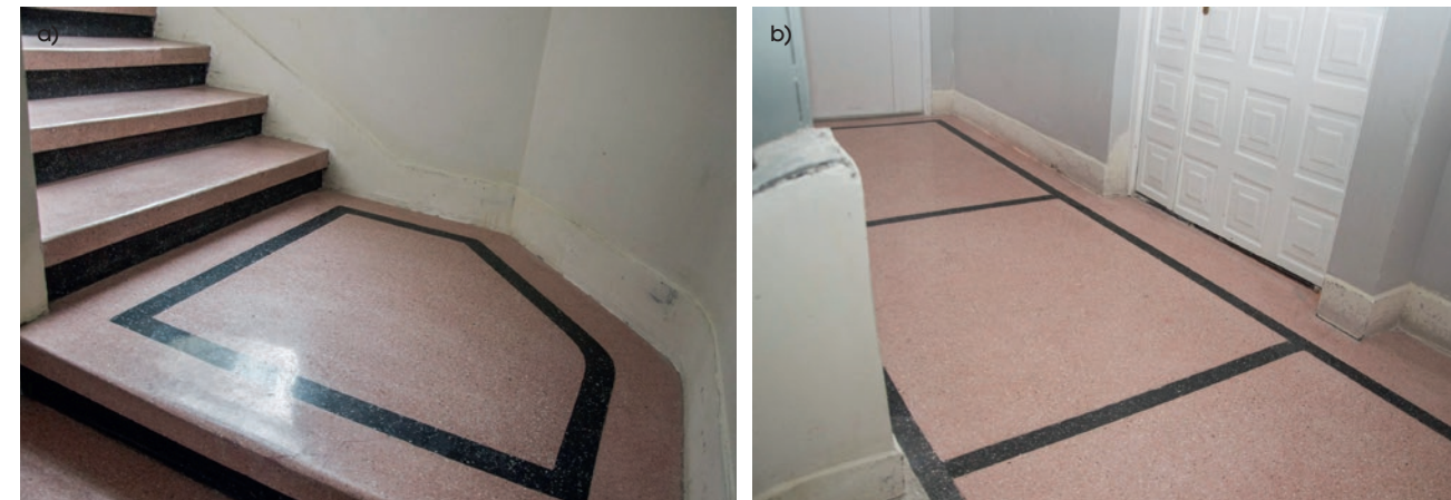
Fot. 3. Renowacja i naprawa kolorowej posadzki typu lastrico w wielorodzinnym budynku mieszkalnym – stan po pracach remontowych: a) wykończenie schodów, b) posadzka w korytarzach (M1)
