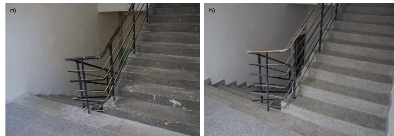
Fot. 1. Renowacja i naprawa posadzki typu lastrico w wielorodzinnym budynku mieszkalnym – posadzka: a) przed naprawą, b) po naprawie (M1)
