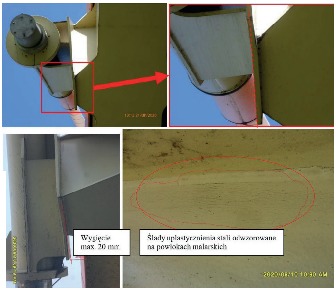
Rys. 4. Przykłady zdeformowanych blach zakotwień wanty i oznaki przeciężenia
