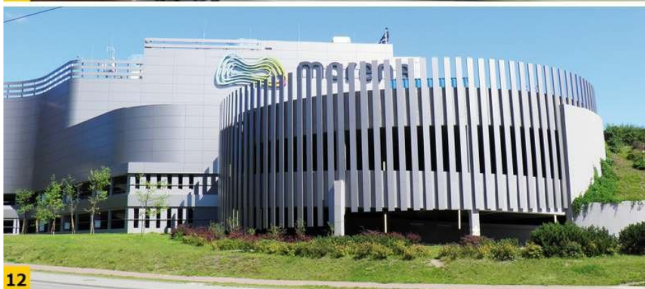
• FOT. 11-12. Centrum handlowe powstałe około 2003 r.: obiekt przed przebudową (11), obiekt po rozbudowie i renowacji elewacji w latach 2015-2016 (12); fot. Dariusz Kowalski
