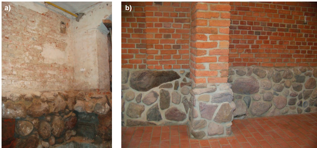
Rys. 2. Widok kamiennej ściany fundamentowej: a) przed i b) po renowacji
