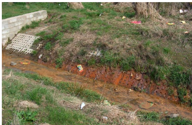
Rys. 10. Zabagnienie terenu przyległego do rowu i spływające do niego żelaziste wody gruntowe
