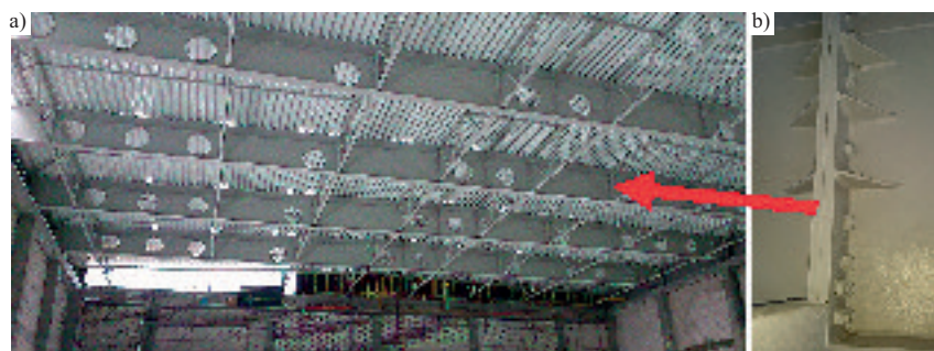
Fot. 1. Hala w trakcie budowy (a) oraz styk doczołowy dźwigara (b) Photo 1. The hall under construction (a) and butt joint (b)
