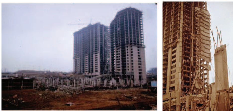
Rys. 1.1. Widok na zniszczony wieżowiec i przyległy parking [118]
