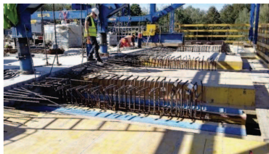
Rys. 5.25. (a) Widok na sekcję 4.4, (b) Deskowanie płyty górnej i zbrojenie środników
