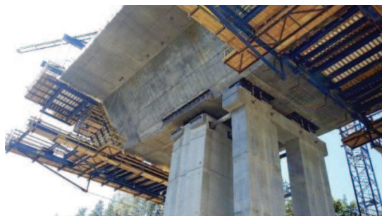
Rys. 5.25. (a) Widok na sekcję 4.4, (b) Deskowanie płyty górnej i zbrojenie środników
