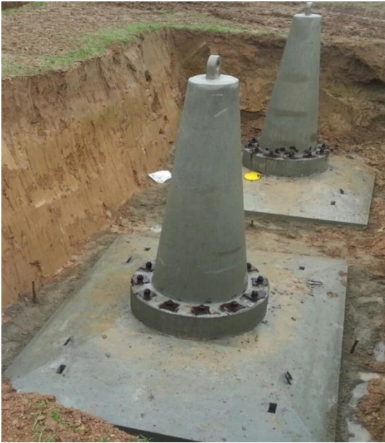
Rys. 6. Fotografia 2 stóp fundamentu słupa linii 400 kV podczas budowy [8]
