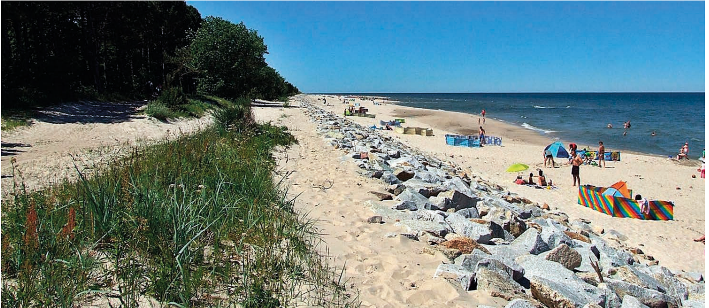
Rys. 9. Trawa na koronie umocnionego wału wydmyowego [1]
