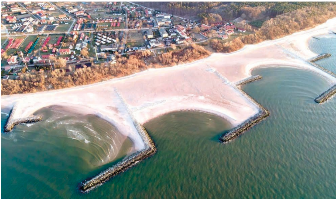
Rys. 13. „Polski Dubaj” – Jarosławiec. Wypełnione ostrogi narzutowe urobkiem za pomocą refulacji [7]
