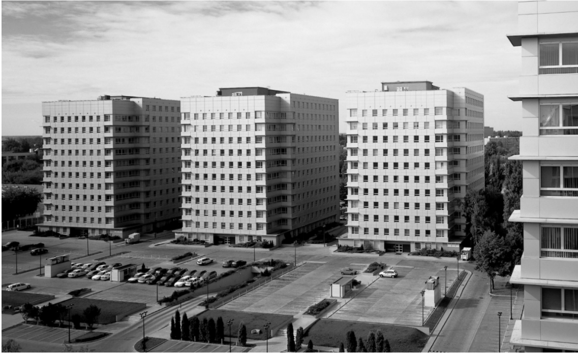
Il. 77. Kompleks Biurowy GTC, Mokotów Business Park, Empark, autorzy JEMS Architekti Źródło: http://jems.pl/projekty/biurowe/mokotow-business-park.html .
