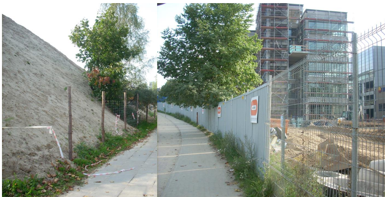
Fot 3. Ażurowa struktura ogrodzenia zabezpiecza plac budowy i jednocześnie pozostawia przechodniom wrażenie otwartej przestrzeni.
